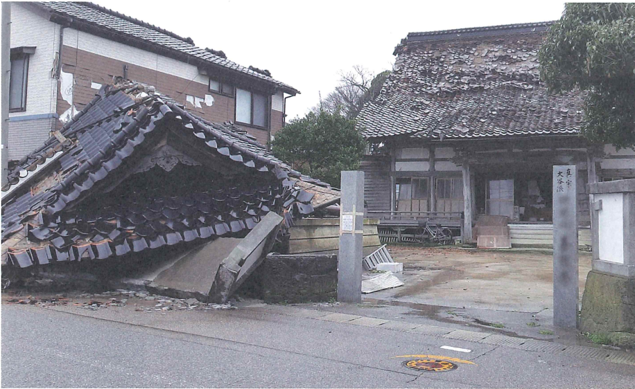
輪島の朝市通りの火災現場近くに、類焼は免れたが半倒壊した真宗大谷派寺院がある。 2024年4月3日撮影 ※一部加工しています / 写真の無断転用はご遠慮ください
